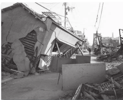
倒壊した家屋
